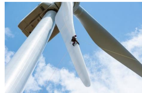
Inspection d'une aube d'éolienne
