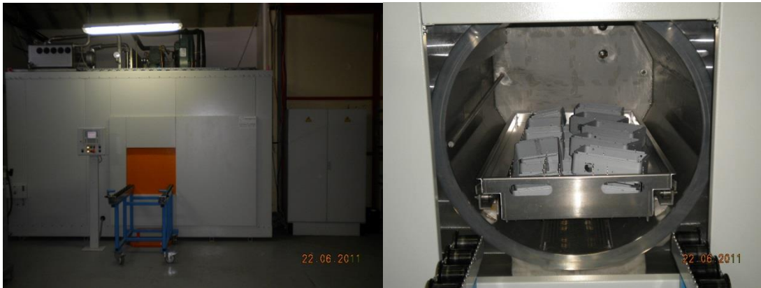
Photos de l'installation
