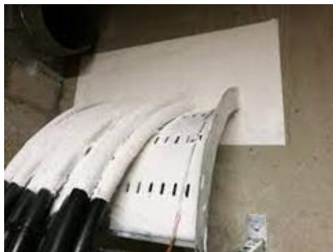
Image 22 : Exemples de système protégeant de la propagation du feu par les passages de câble
