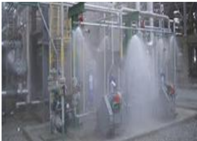
Image 26 : Exemple de sprinklage « Eau » d'équipements industriel
